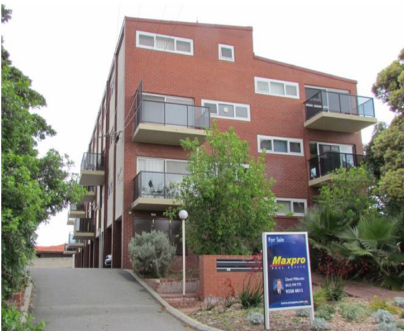
1970's Walkup Flats
