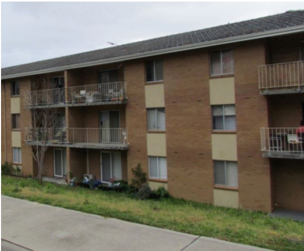
1960's Walkup Flats
